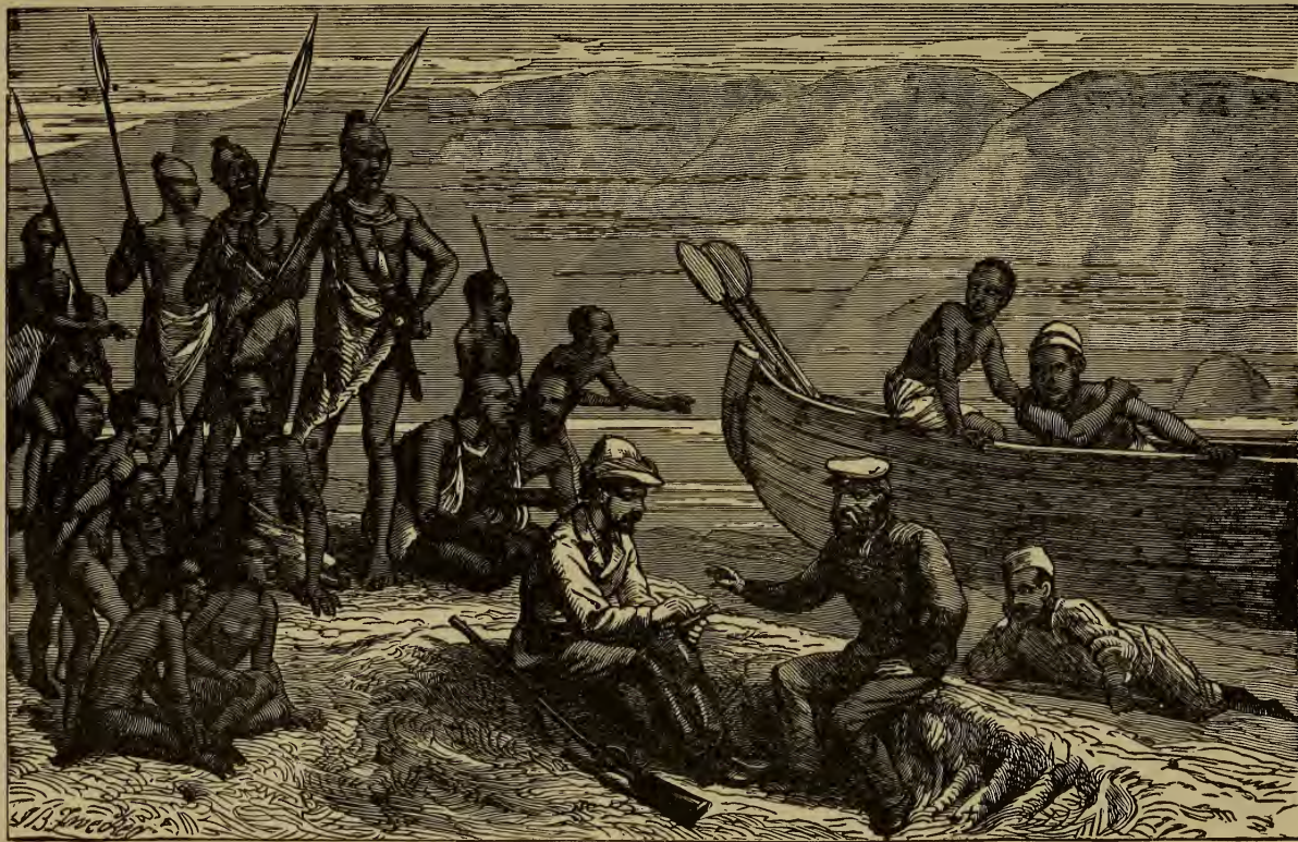
LEVEE AT MAGALA-URUNDI.
